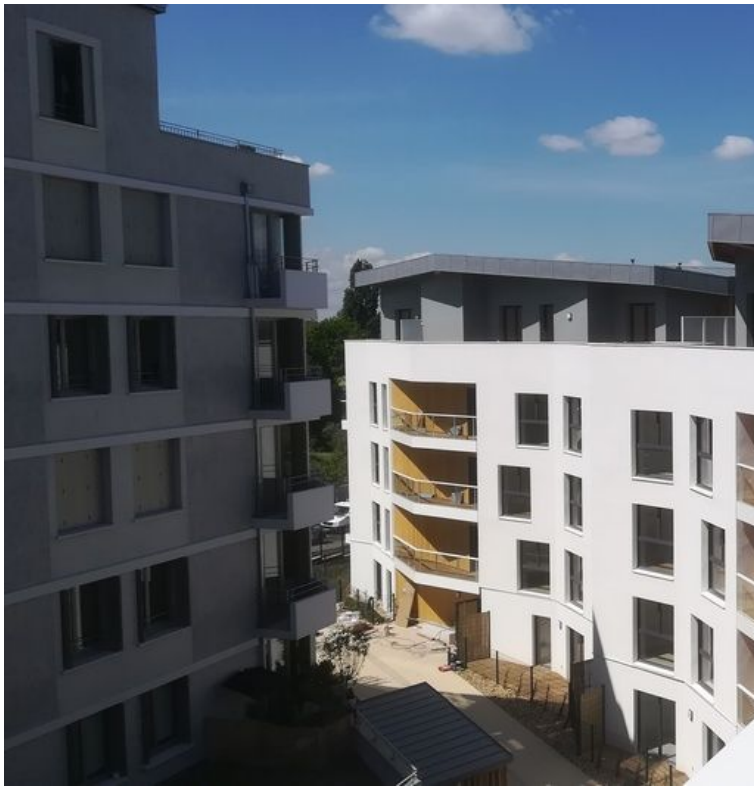
Construction en CLT (bois lamellé croisé) de 3 bâtiments neufs, en R+3 + attique, avec un total de 90 logements à Bry-sur-Marne (94).
